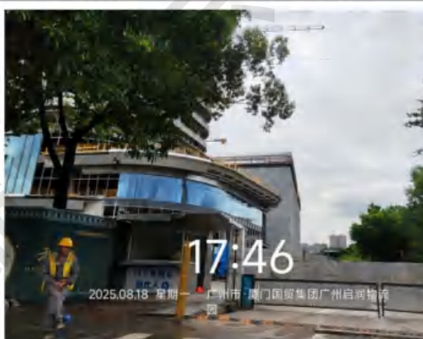
项目西面 在建工地
