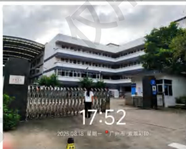
项目北面 广州天盛印刷有限公司
